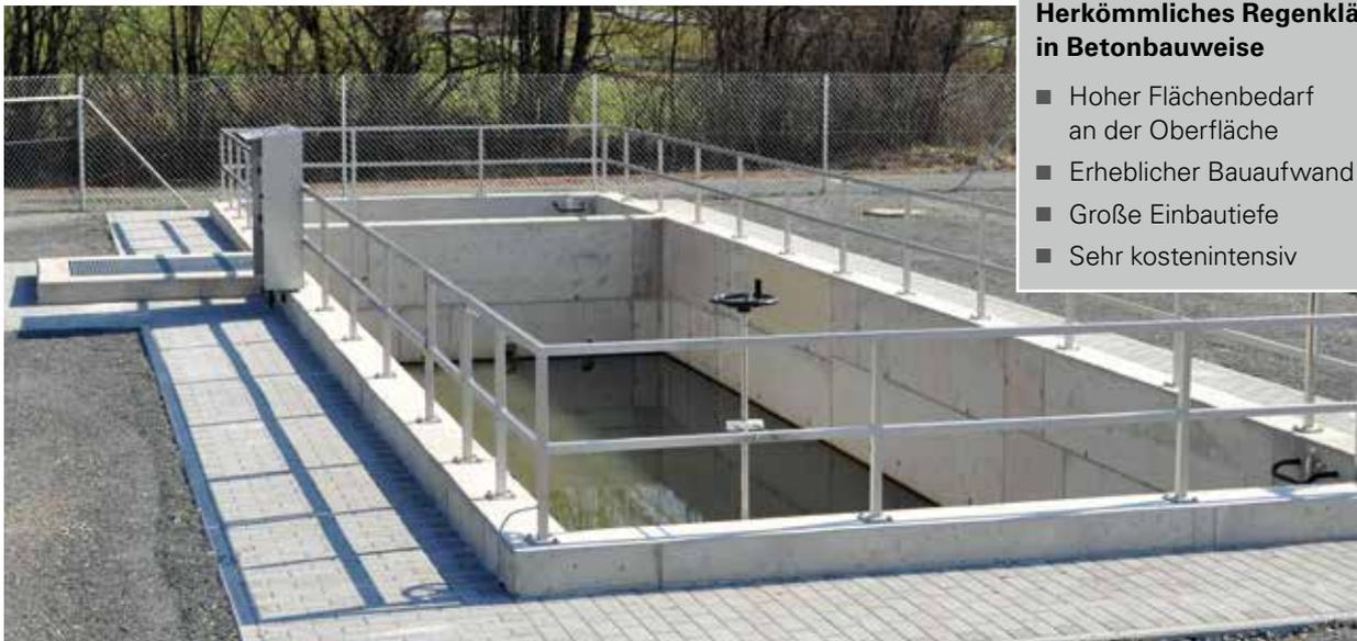
Regenklärbecken in Betonbauweise
