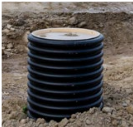
Opføringsrør med byggepladsafdækning
