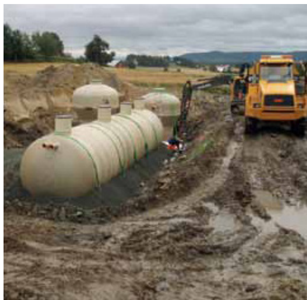
Slamavskiller med infiltrasjon under bygging.
